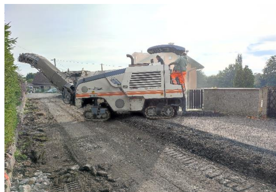
Oprava místní komunikace ke mlýnu
